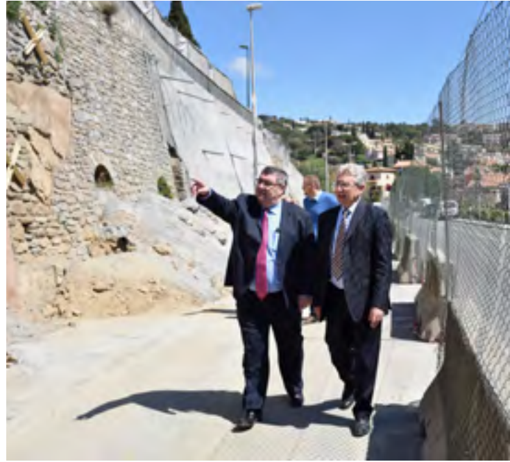
Marc Giraud et Gil Bernardi sur le chantier de sécurisation du talus de l'Avenue de Provence
