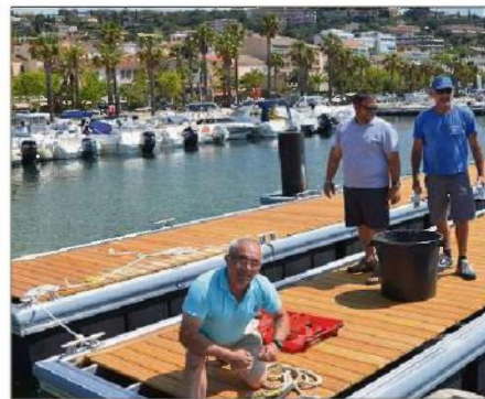
F. B. Réhabilitation des pannes par les agents du port.
