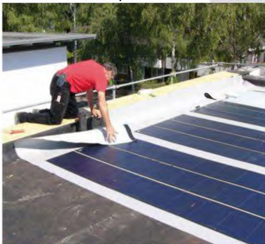
Membrane souple – Toit Terrasse
